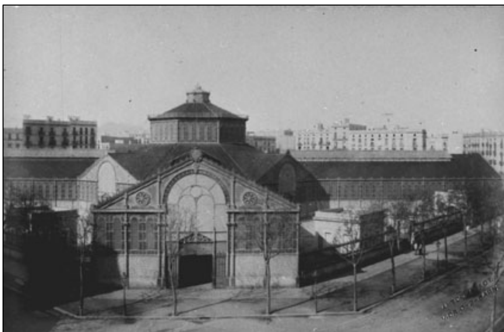
Fig. 8. Fotografia d'Antoni Rovira i Trias de l'exterior del Mercat de Sant Antoni a l'any 1878 (Font: Arxiu Històric del Col·legi d'Arquitectes de Catalunya)
